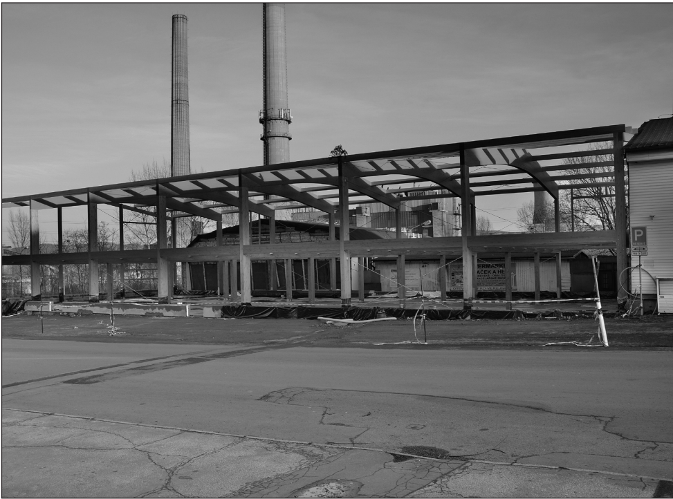
Dřevěný skelet budoucí privátní galerie historických automobilů už na Štefánikově ulici stojí. První návštěvníky budova přivítá na přelomu léta a podzimu.
