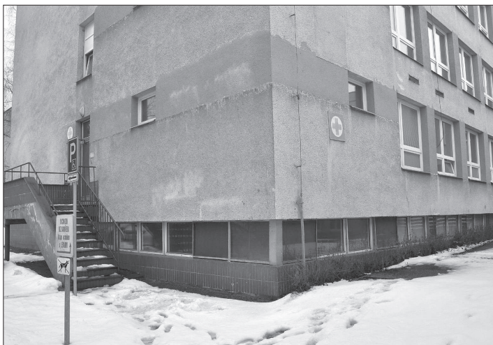
V přízemí tohoto křídla budovy zdejší polikliniky by mohlo v blízké budoucnosti vzniknout sociální bydlení určené především pro seniory. FOTO: DAVID MACHÁČEK
