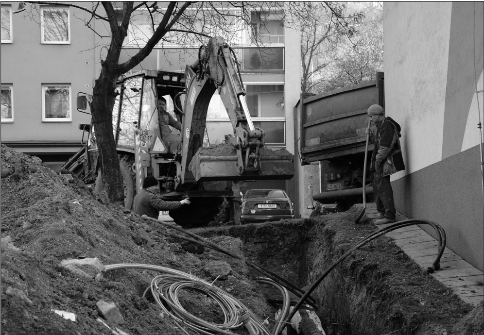
Stavební čtyři po položení potrubí a kabelů zahrnují výkopy, aby v případě příchodu zimy mohla být prováděna údržba chodníků a parkovišť. Práce přeruší jen na svátky. FOTO: DAVID MACHÁČEK
