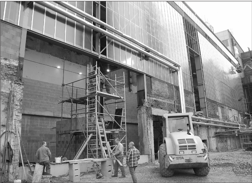
V rámci instalace nového kotle na spalování biomasy se oprav dočkal také prosklení haly teplárny společnosti Komterm.
