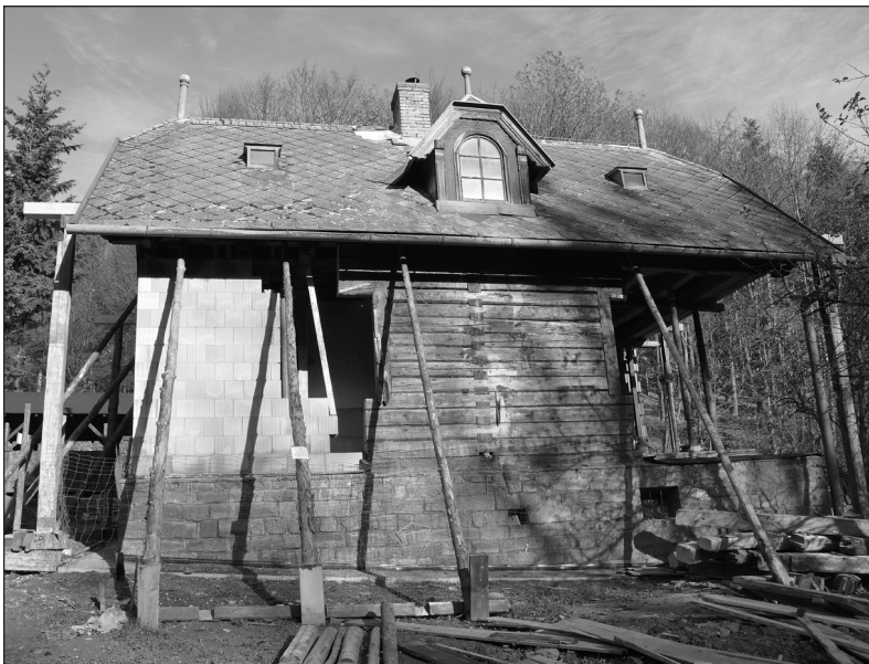
Původní roubenou část Hájenky na Janíkově sedle nahrazuje cihlová zeď. Po dokončení oprav by měl objekt vypadat zase jako dřív. FOTO: D. MACHÁČEK
