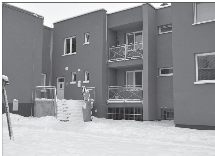
Pohled na rekonstruovaný azylový dům s přístavbou pro denní centrum, která propojila dva původně samostatné stojící objekty. FOTO: DAVID MACHÁČEK
