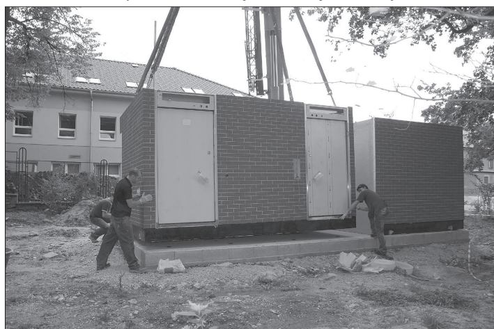
Snímek zachycující stavbu veřejných záchodků v centru města. Na začátku tohoto týdne byl zahájen jejich provoz. WC v parku Edvarda Beneše budou otevřeny denně od 6 do 20 hodin. Součástí dámských záchodů je také přebalovací pult. WC disponují také toaletami pro invalidy. Vstup do místnosti toalet je zpoplatněn, pisoiry je možné využít zdarma. FOTO: DANA HOĐÁKOVÁ
