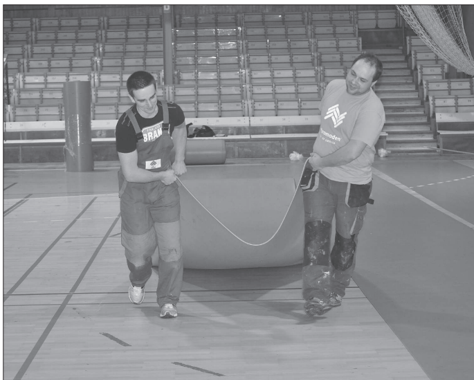
Nový povrch byl v hale ZŠ E. Zátopka pokládán v jednotlivých pásích. Pracovníkům brněnské specializované firmy kompletní práce trvaly pět dní. FOTO: JANA FEILHAUEROVÁ
