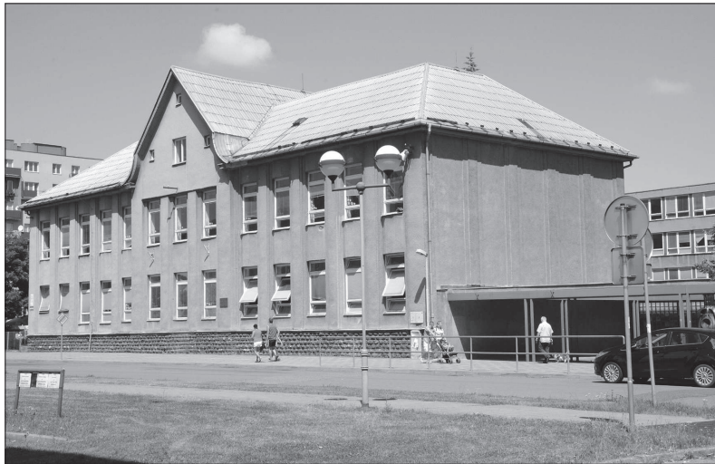
Tato podoba Základní školy dr. Milady Horákové by již brzy měla být historii. Včera nastoupily stavební čety, které budou provádět kompletní zateplení budovy; což si vyžádá odložení začátku výuky. FOTO: DAVID MACHÁČEK
