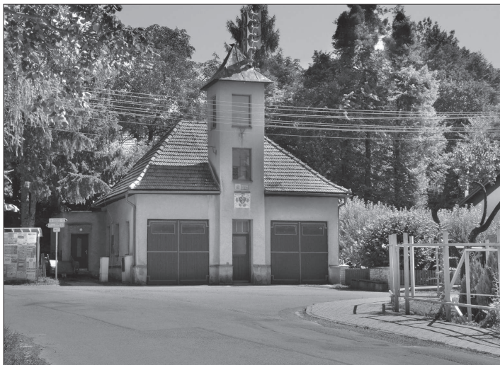
Jak tvrdí místní, hasičská zbrojnice ve Větrkovcích se za posledních dvacet let nezměnila. Letos došlo nejen k výměně sirény, ale i na nátery vrat.
