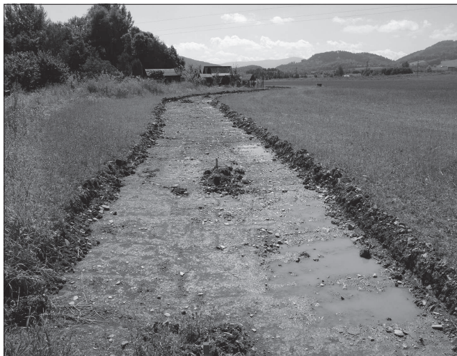
Zatím jen podkladní vrstvy naznačují trasu nové budované cyklostezky z Lubiny do Vlčovic, která by měla být dokončena do konce září. FOTO: DAVID MACHÁČEK
