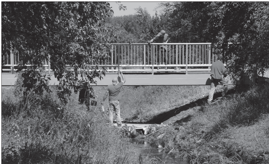
Dvě z lávek pro pěší přes Kopřivničku projdou v letošním roce větší rekonstrukci. Práce na lávce spojující ulici Francouzskou a Dolní již finišují. Další na řadě je lávka u Mateřské školy Kráka.
