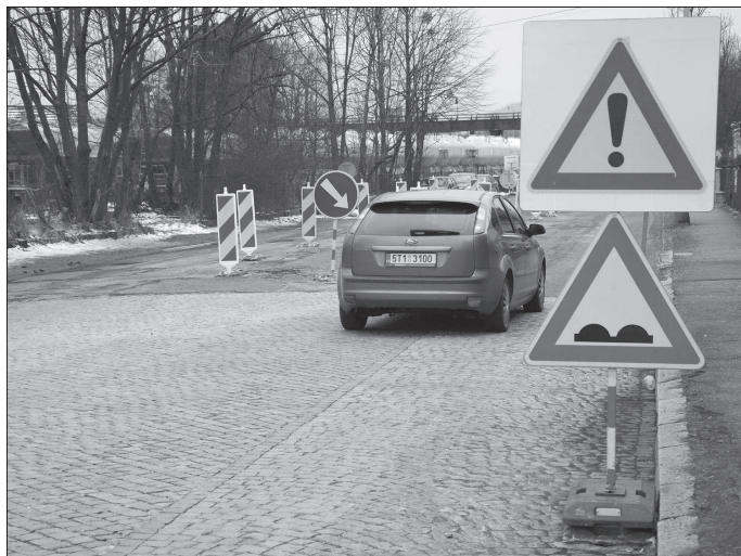
Jeden z nehorších úseků silnic v Kopřivnici je v horní části ulice Štramberské. Zde by mělo dojít k rozsáhlejší opravě.
