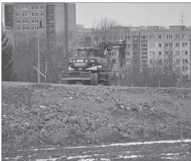
V těchto dnech byly obnoveny práce na rekonstrukci železničního nadjezdu a také nové na budovaném sjezdu na ulici Dělnickou.
