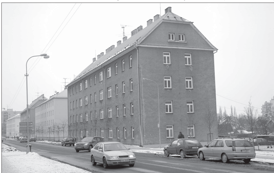
Městské domy na ulici Obránců míru se záhy dočkají zateplení a rekonstrukce. Město na ně použije také prostředky z dotačního programu Zelená úsporám. Práce by měly začít už v březnu a skončit do konce května.
