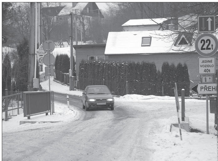
Zatáčka na Velovou je kvůli své šířce pro řidiče velmi nepřehledná. Během několika následujících měsíců zde bude panovat čilý stavební ruch, během kterého dojde k jejímu rozšíření. FOTO: DAVID MACHÁČEK
