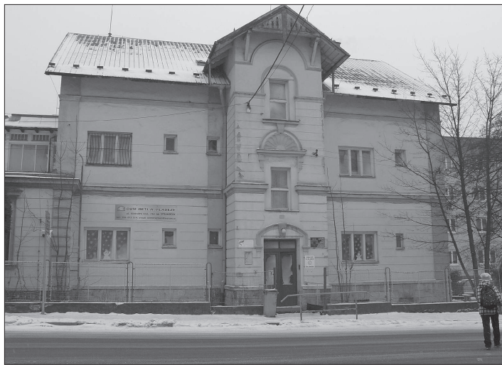
Budova Domu dětí a mládeže ve Štamberku by mohla projít rekonstrukcí. Zásah by potřeboval nejen interiér, ale hlavně samotná budova.
