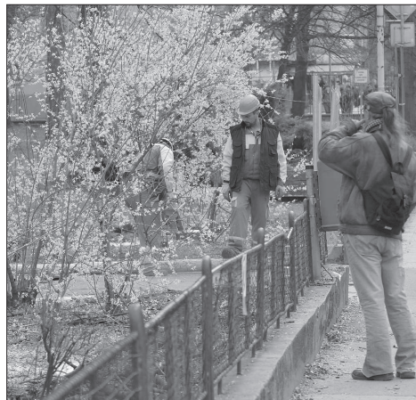
Před zahájením stavby musely být odstraněny dřeviny v bezprostřední blízkosti rekonstruované ulice.
