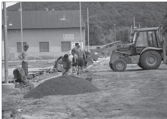
Celé letošní léto byla ulice Štefánikova i prostor bývalé křižovatky u Kachlovky staveništěm, které komunikovalo nejen automobilovou dopravu, ale také pohyb chodců.
