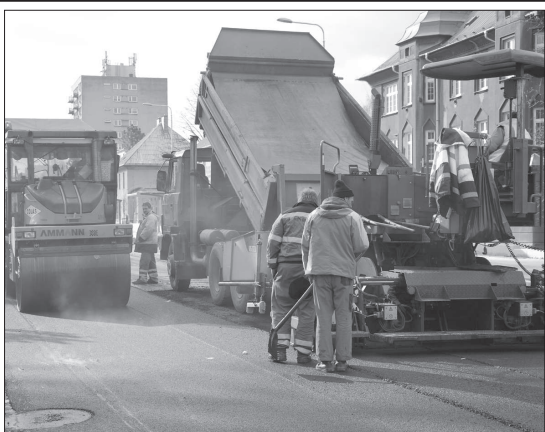
Finální vrstva asfaltového povrchu byla pokládána v závěru minulého týdne. V neděli už ulici projížděly linkové autobusy.
