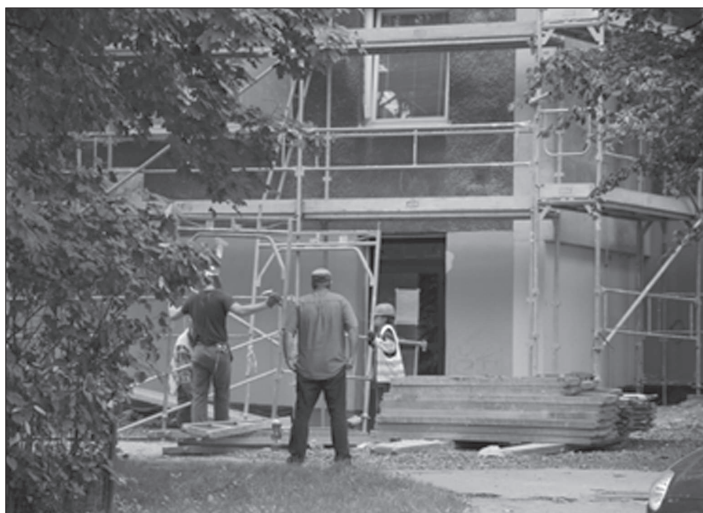
Již od roku 2009 probíhají rekonstrukce bytových domů na sídlišti Jih ve vlastnictví města. Někteří nájemníci si na postup stavebních firem stěžovali.
