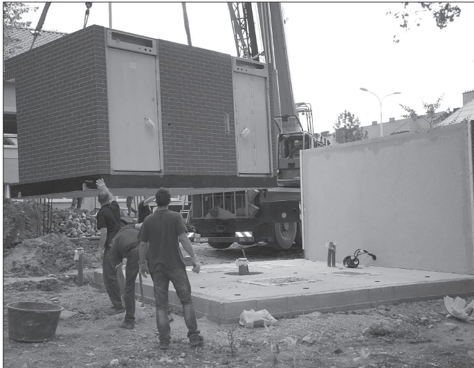
V minulém týdnu byly na připravený základ v parku E. Beneše instalovány buněky budoucích veřejných záchodků. Ty mají začít sloužit veřejnosti koncem roku.
