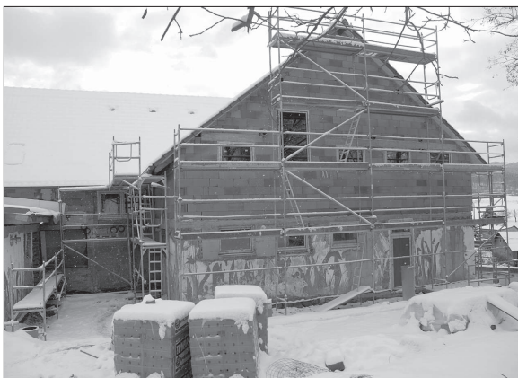
Přesto, že stále není dokončena, je rozestavěná budova Základní školy v Mníši už nyní výrazně objemnější než její předchůdkyně.
