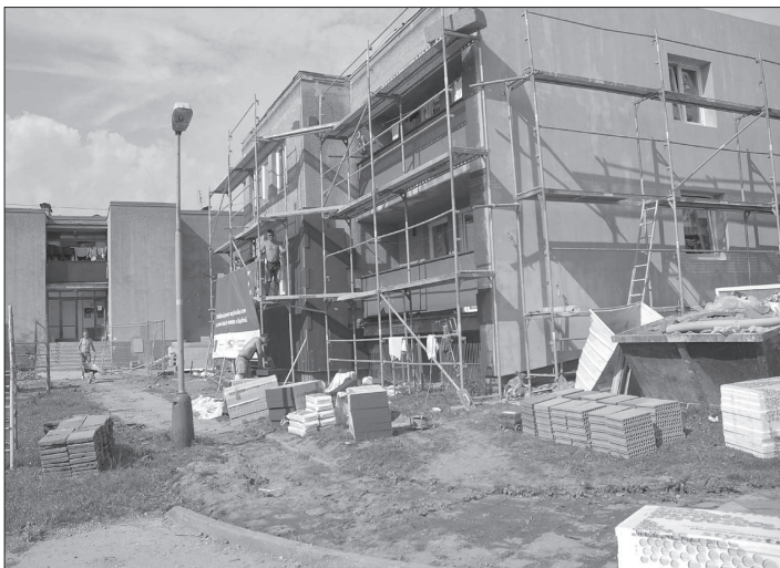
Hrubá stavba přístavby stávajícího azylového domu by měla být dokončena tento týden. Projekt podpořeny dotačními penězi zatím běží podle plánu. FOTO: DAVID MACHÁČEK
