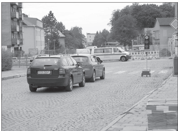
Až do konce října bude provoz na křižovatce u Katolického domu řízen semaforem. Důvodem omezení provozu je stavba okružní křižovatky. FOTO: DAVID MACHÁČEK
