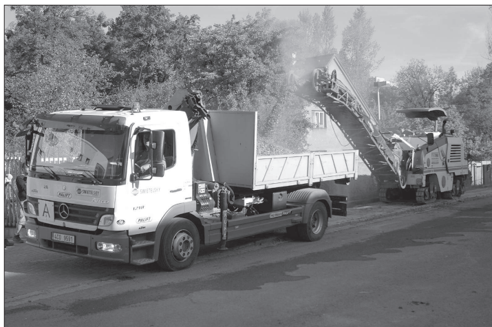
Práce na letos posledním úseku cyklostezky kolem Kopřivničky byly zahájeny v uplynulém týdnu. Celá cyklostezka má být dokončena až v příštím roce.
