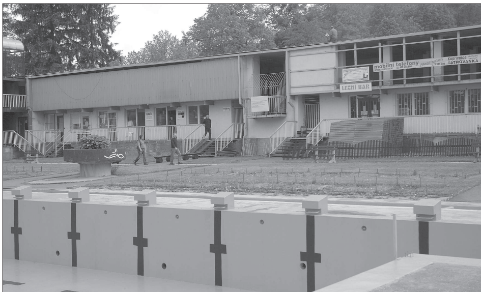
Předsezonní přípravy na letním koupališti finišují. Bazény už jsou připraveny, v tomto týdnu probíhaly opravy střešiny budovy se zázemím koupaliště. Pokud počasí dovolí, sezona by měla začít na konci května.
