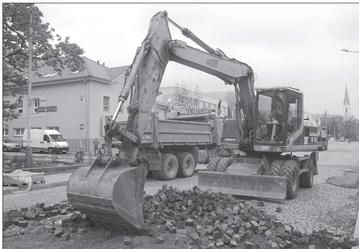
Proměna ulice Štefánikovy pokračuje. Poté, co byly odstraněny stromy bránící rekonstrukci, v minulém týdnu začaly bagry rozebírat dlažební kostky, které tvořily povrch silnice desítky let. FOTO: DANA HOĐÁKOVÁ
