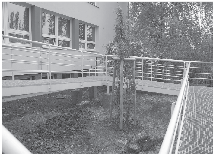
Vloni prošla Materská škola na ulici Krátké stavební rekonstrukcí a letos je u ní prováděna nová výsadba. V minulém týdnu byly vysazeny stromy a v tomto trvalky, trávy a keře. FOTO: DANA HOĐÁKOVÁ
