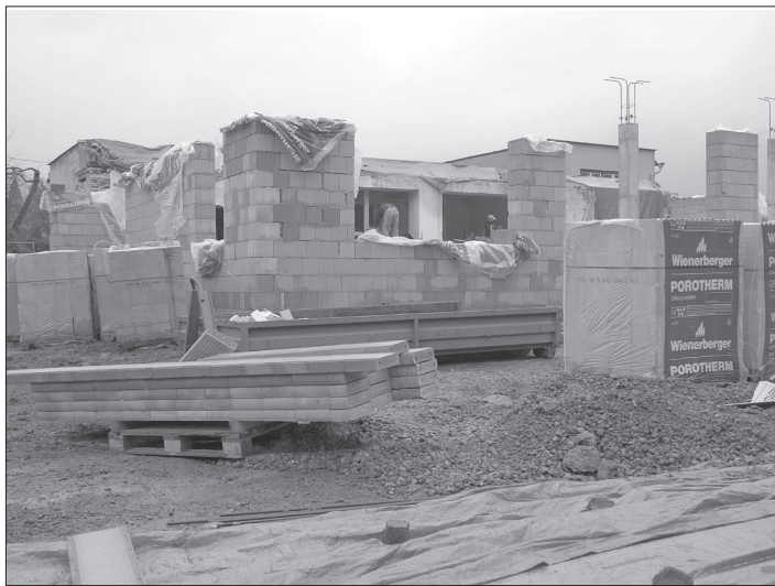
Stavební práce na rekonstrukci hasičské zbrojnice v Kopřivnici se už rozběhly naplno. Jednotka dobrovolných hasičů by nové prostory mohla začít využívat koncem roku. FOTO: DAVID MACHÁČEK
