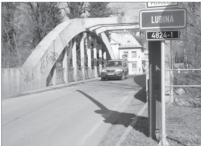
Také oprava silničního mostu v Lubině je v plánech Správy silnic Moravskoslezského kraje. Práce, v rámci kterých na mostě vznikne i chodník, jsou v plánu v roce 2013. FOTO: DAVID MACHÁČEK
