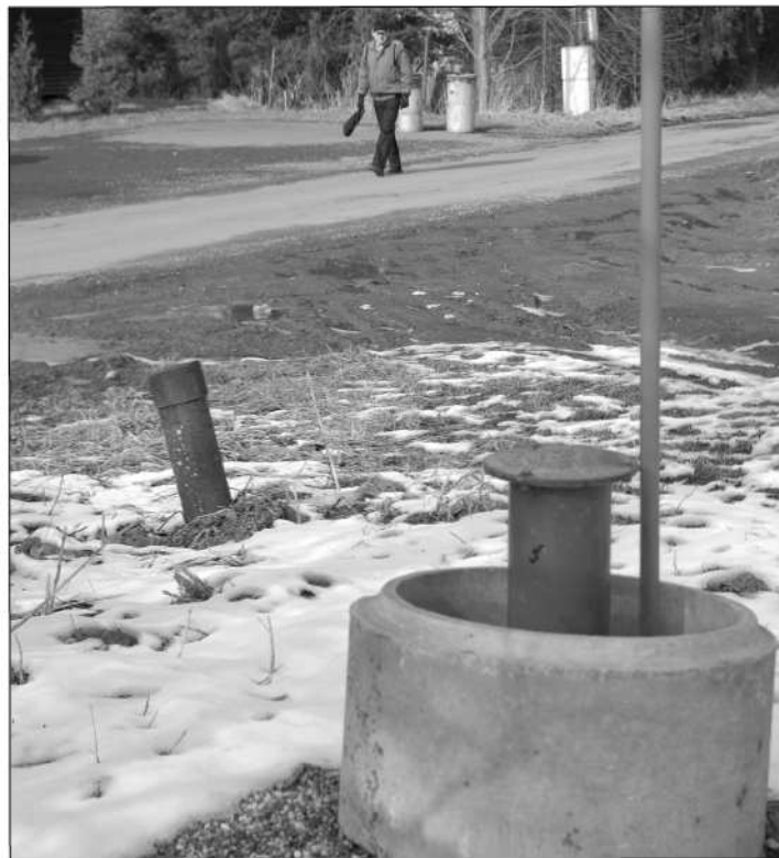
Průzkumné vrty v místech někdejší skládky kalů prokázaly, že pod zemí se nacházejí nebezpečné látky. Nejdražší varianta sanace by mohla přijít až na 180 milionů korun. FOTO: DAVID MACHÁČEK
