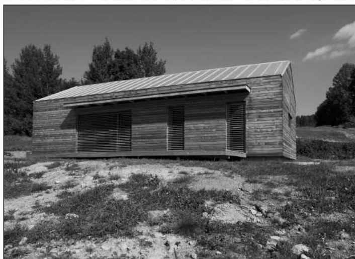
S touto i dalšími realizacemi architektonického studia Kamila Mrvy se bude moci veřejnost podrobně seznámit v rámci připravované výstavy v Katolickém domě.
