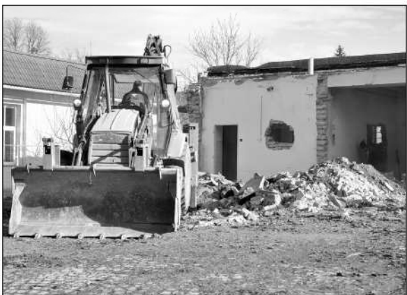
Jen malá část původní budovy hasičské zbrojnice odolala aktuálním probíhající demoličním pracím, které zahájily rekonstrukci. FOTO: DAVID MACHÁČEK
