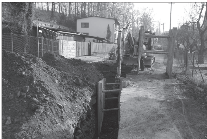
Budování kanalizační sítě v Lubině přeje počasí. Práce probíhají na více místech najednou a zastaví je až sněhová nadílka.
