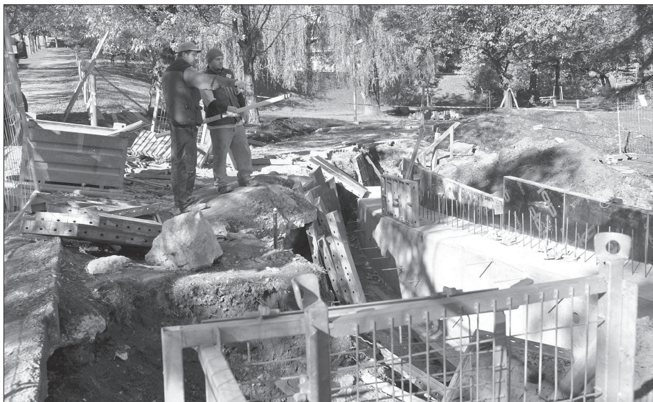
Před stavbou cyklostezky od Husovy ulice k mostu na Erbenově ulici bylo nutné postavit opěrnou stěnu. Práce na stavbě cyklistické komunikace kolem Kopřivnický pokrácují rychleji, než bylo původně plánováno.
