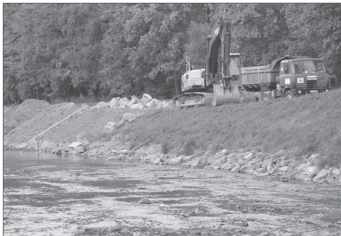
Na úpravu koryta a pravého břehu řeky Lubiny nastoupila těžká technika. Po loňských povodních, kdy řeka utvořila nové řečiště, se napravlují vzniklé škody.
