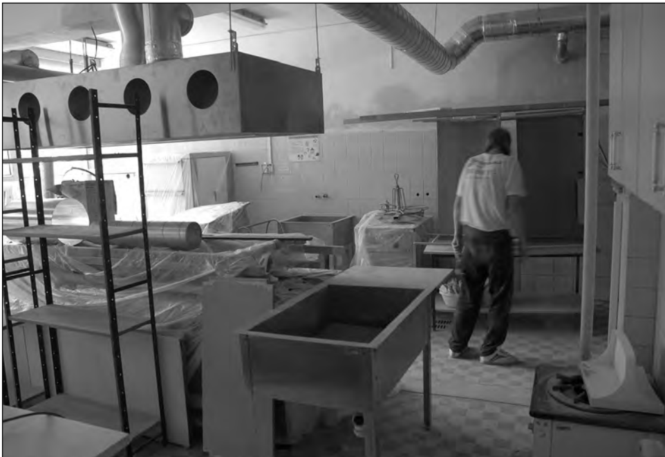
V kuchyni v Mateřské škole Krátká nebyly do pátku 26. srpna dokončeny stavební práce, ani vymalována. Do zahájení provozu musí být uklizena a zásobena potravinami. FOTO: DAVID MACHÁČEK
