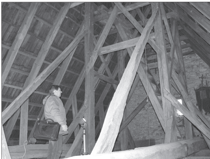
V pondělí dopoledne zprístupnila štramberská farnost kostel sv. Kateřiny k prohlídce firmám, které se budou ucházet o veřejnou zakázku. FOTO: ILONA MAZALOVÁ
