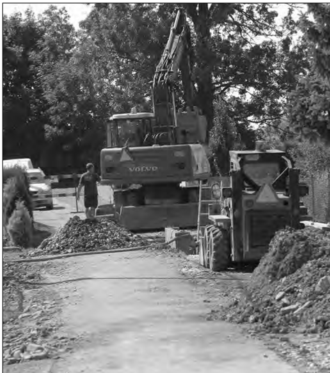
Rozsáhlý projekt odkanalizování místní části Lubiny se aktuálně realizuje na třech místech v obci. FOTO: DAVID MACHÁČEK
