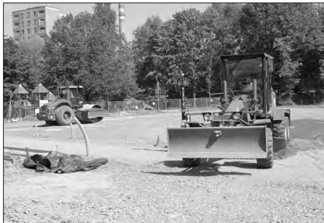
Stavební stroje připravují podloží, na kterém bude již za pár týdnů nové sportovní hřiště ZŠ Milady Horákové. FOTO: D. MACHÁČEK
