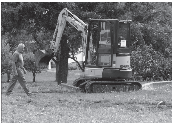
Práce na rekonstrukci zahrady v Mateřské škole v Lubíně se rozjely naplno, po jejím dokončení se zahrada promění v Ptačí svět.
