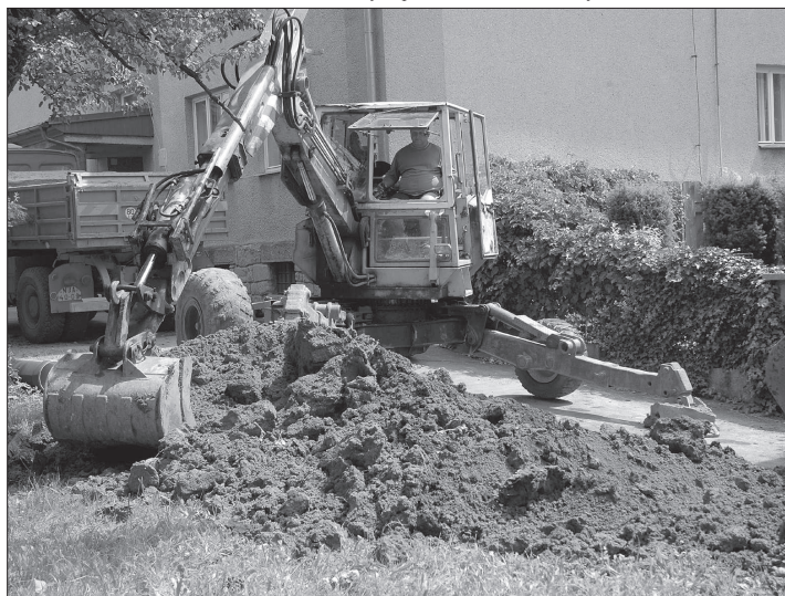
Stavební stroje firmy Zlínstav začaly práce na budování kanalizace v Lubině a na dalších třech místech na Novojičínsku. FOTO: DAVID MACHÁČEK
