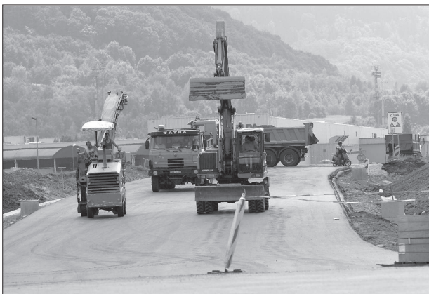
Napojení komunikace vedoucí do průmyslového parku a Tatro se silnicí I/58 má být zprovozněno již v neděli 19. června. Časový plán se daří plnit. FOTO: D. MACHÁČEK
