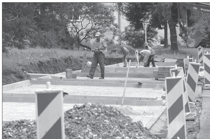
Ve Štamberku na Bařinách se budují nejen nové chodníky, ale i nová parkovací stání. Stavební práce by měly být dokončeny do konce letošního roku.
