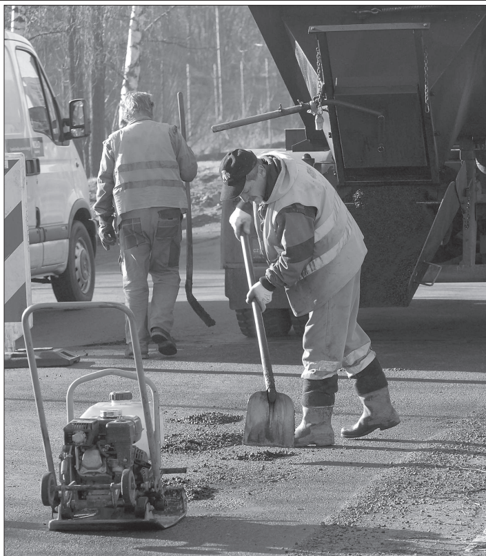
Oblevy využilo Slumeko k opravám některých nebezpečných výtluků na silnicích. Na začátku týdne pracovali na ulici Dělnické, která už balancovala na hranici sjízdnosti. FOTO: DAVID MACHÁČEK
