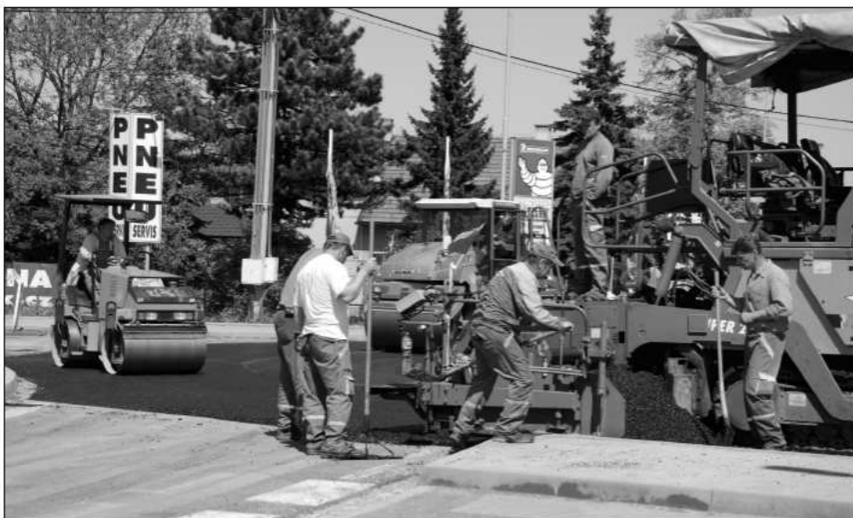
Po víc jak roce bude možné opět projet Lubinou ve směru na Frenštát. Naopak stavební práce uzavřou do prázdnin dosavadní objízdnou trasu vedoucí ulicí Ke Křížku.
