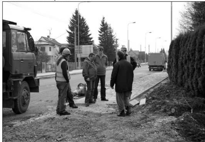
Až do zprovoznění komunikace na Frenštát budou probíhat pravidelné kontroly provedených stavebních prací, aby se předešlo pozdějším reklamaci.
