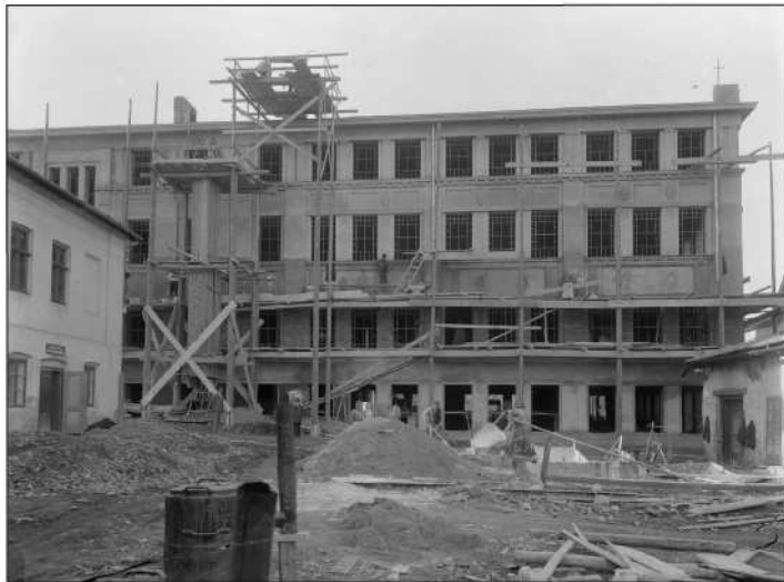
Snímek z roku 1911 zachycující stavbu budovy dnešní Základní školy sv. Zdislavy na ulici Štefánikově.
