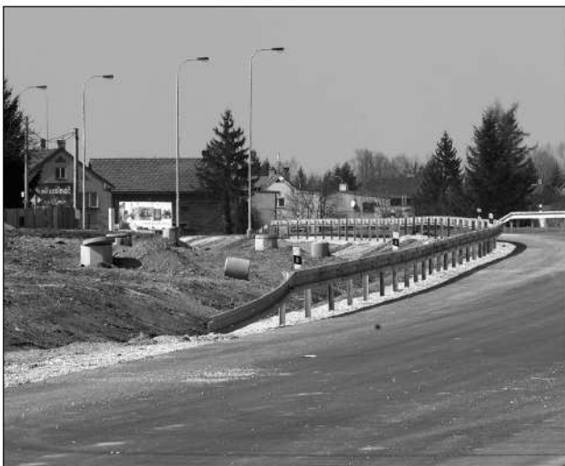
Nová silnice vedoucí z Lubiny směrem na Frenštát zatím zeje prázdnotou, přestože se zdá již dokončená. Komunikace má být otevřena zhruba za šest týdnů. FOTO: DAVID MACHÁČEK
