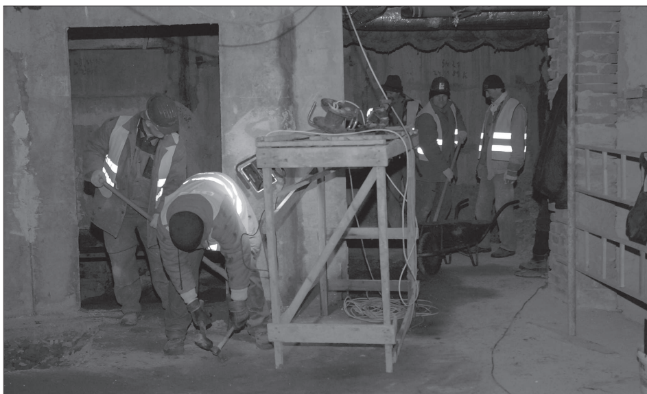
Demoliční práce na objektu budoucí stravovny domova pro seniory jsou už skončeny. Tento týden dělníci dokončují kanalizaci. Přestože stavba má být hotova až v září, budoucí provozovatel dietní kuchyně je již znám.
