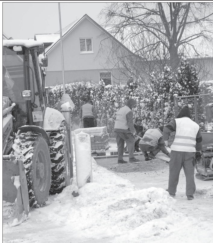
Privály sněhu značně zkomplikovaly stavební práce na průtahu Lubinou. Jeho otevření běžnému provozu se tak protáhne o další měsíce.
