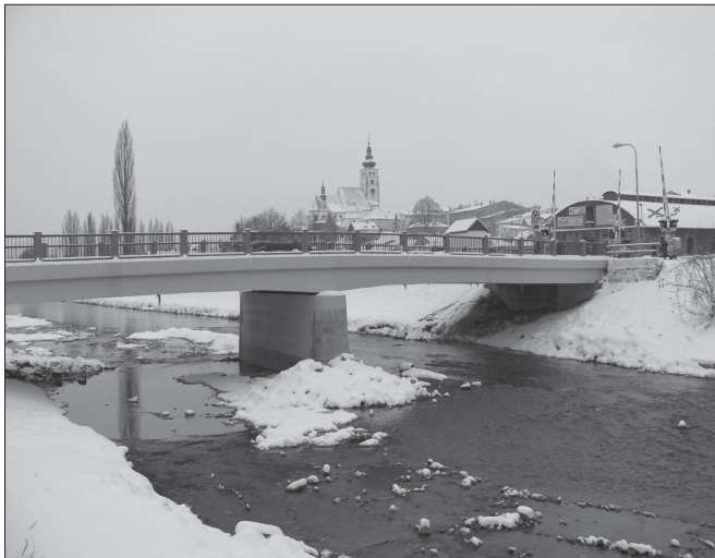
Klokočovský most je po pěti měsících opět v provozu. Během té doby prošel výraznými opravami, za něž Moravskoslezský kraj zaplatil devatenáct milionů.
