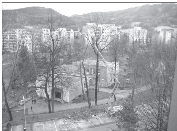
Celkem 43 stromů musí být vykáčeno z důvodu svého špatného zdravotního stavu. Stromy jsou káceny za použití plošiny. FOTO: DANA HOĐÁKOVÁ
