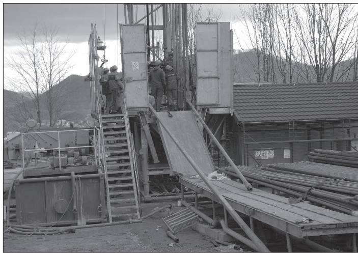
Pracovníci firmy MND servisní, a. s., pracují na opravě jedné z vtláčecích sond podzemního zásobníku zemního plynu na pomezí Štamberka a Kopřivnice. FOTO: DAVID MACHÁČEK
