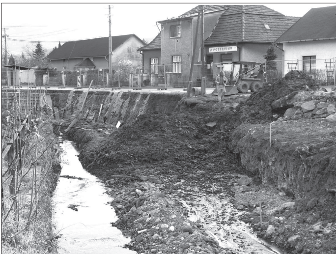
V Ženkla vá probíhají práce na zpevnění břehů, které podemlela velká voda. Ta se obcí prohnala vloni v létě. Stavební práce omezily dopravu, která je řízena semaforem. FOTO: ILONA MAZALOVÁ
