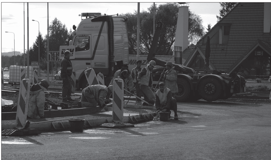
Z důvodu deštivého počasí nebyla firma schopna připravit stavbu tak, aby mohl být obvodový prstenec betonován za pomoci strojů v sobotu 4. září, kdy měla být doprava touto křižovatkou zastavena úplně. Firma byla nucena změnit technologický postup a místo strojů se obvodový prstenec betonoval ručně v průběhu minulého týdne za plného dopravního provozu.
