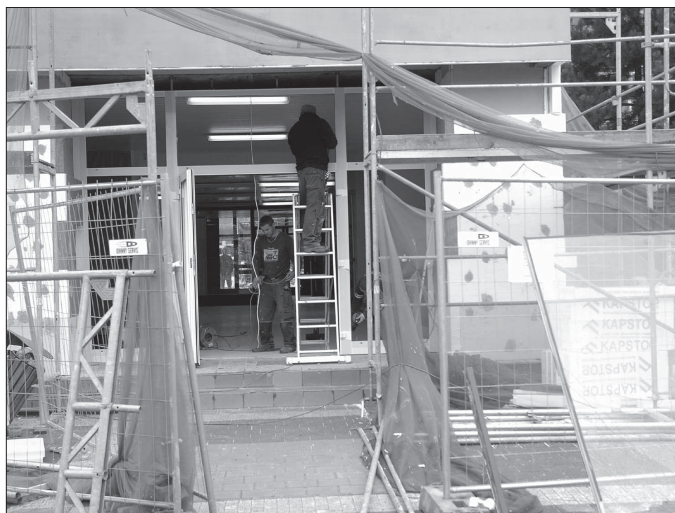
Nedokončená rekonstrukce vstupu do Základní školy na ulici 17. listopadu zapříčinila, že zde školní rok začne až na začátku příštího týdne.
