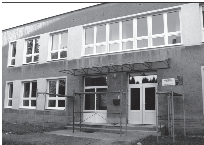
Mateřská škola Pionýrů v Příboře procházela přes prázdniny náročnou rekonstrukcí, díky níž se dětem posunul začátek školního roku na 6. září.
