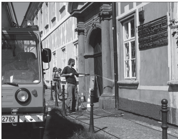
Čištění fasády piaristické koleje se provádí pravidelně. Letos se navíc na budově opravovaly parapety. FOTO: ILONA MAZALOVÁ
