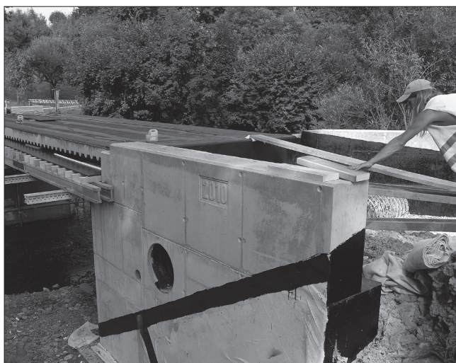
Nový most přes Lubinu na Holotě zatím působí dojmem stavby ve fázi rozpracovanosti. Veřejnosti by však měl začít sloužit od 1. září.
