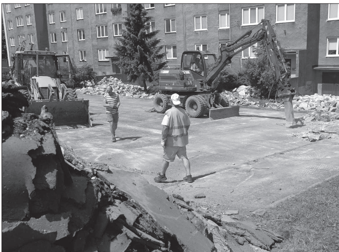
Práce na první etapě revitalizace veřejných prostranství v oblasti sídliště Jih začaly demolicí současných povrchů parkovišť a chodníků v okolí ulice Šramberské.
