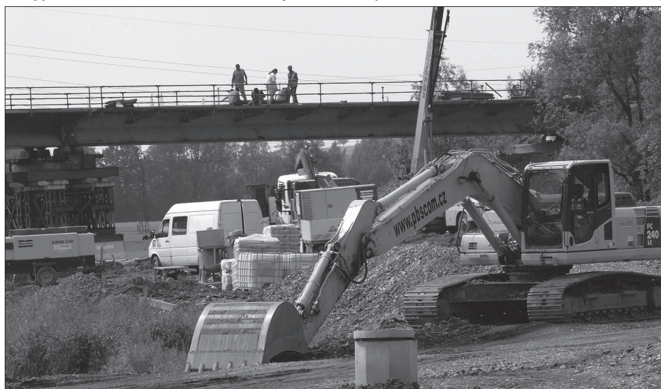
Během minulého týdne vzniklo v místě budoucího křižení silnice se železnici prozatímní přemostění. Stavba příborského obchvatu zatím pokračuje podle plánu.
