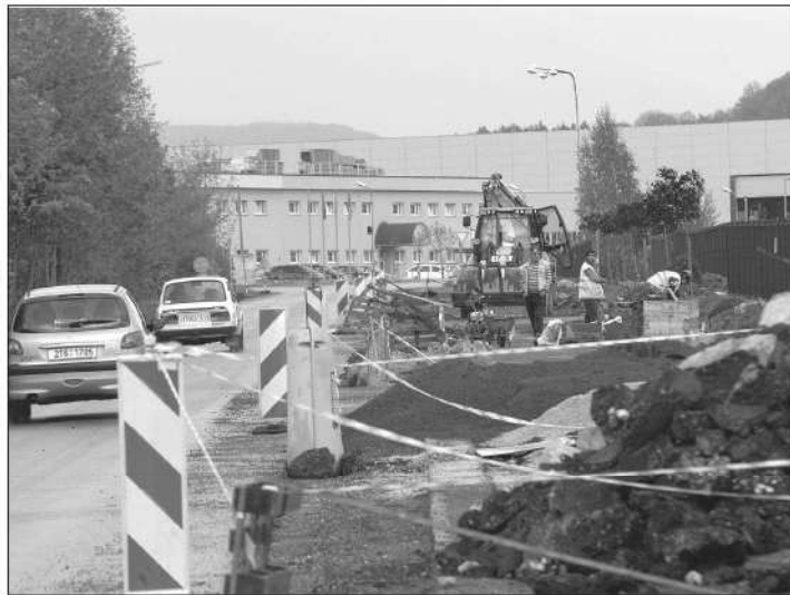
PANSKÁ: Práce na rekonstrukci a dovybavení ulice Panské jsou již v plném proudu. I díky patnáctimilionové dotaci krajského úřadu, ale také díky příspěvkům firem z podnikatelského parku zde vyrostou chodník, cyklostezka, veřejné osvětlení nebo autobusové zálavy.
